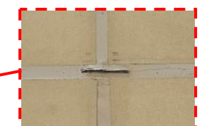
欠損 PL 挿入状態
