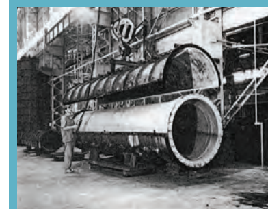
● 型枠脱板
