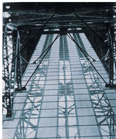
▲ 東京タワーエレベーター部に使用
